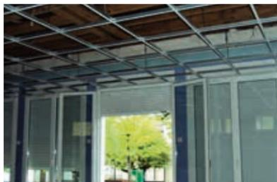
Avant de déposer l'amiante localisée dans les dalles de plafond, l'entreprise en charge des travaux a protégé tous les éléments susceptibles d'être exposés pendant le désamiantage (meubles, radiateurs...), elle a ensuite procédé au confinement et à l'extraction de l'air. Les dalles contenant de l'amiante ont été ainsi mises en sac et traitées ensuite par une filière spécialisée.
